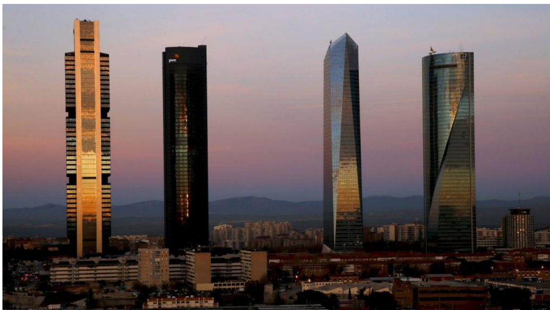
Las cuatro torres, la segunda de ellas sede de PwC en Madrid. (EFE)
