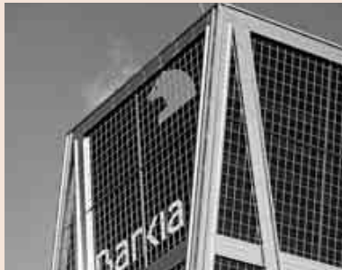
Fachada de la sede central de BFA-Bankia.
